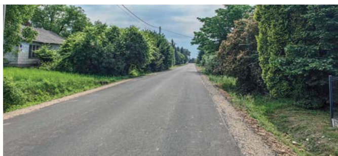
Modernizacja drogi w Łabuńkach Drugich w stronę Mocówki. Długość odcinka drogi: 420 m
