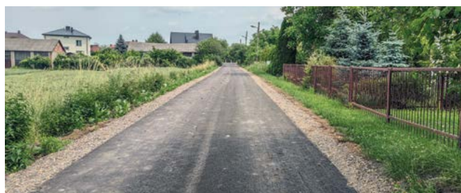
Modernizacja drogi w Łabuniach, ul. Ogrodowa. Długość odcinka drogi: 170 m
