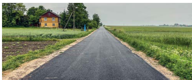
Modernizacja drogi w Ruszowie – Przecięcie. Długość odcinka drogi: 750 m
