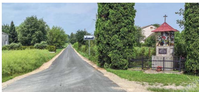
Modernizacja drogi w Mocówce od Sachalinu. Długość odcinka drogi: 420 m
