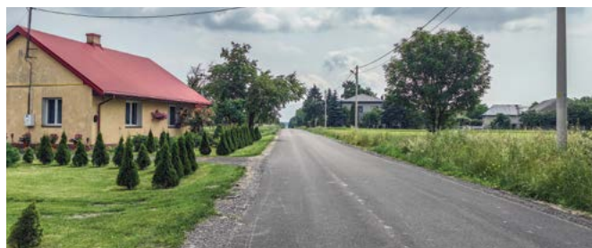
Modernizacja drogi w Łabuńkach Pierwszych – Przemiarki. Długość odcinka drogi: 1 760 m
