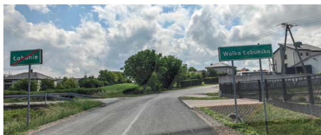
Modernizacja drogi w Wólce Łabuńskiej – Błonie. Długość odcinka drogi: 750 m
