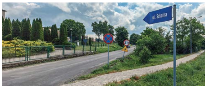
Modernizacja drogi w Łabuniach, ul. Szkolna. Długość odcinka drogi: 480 m
